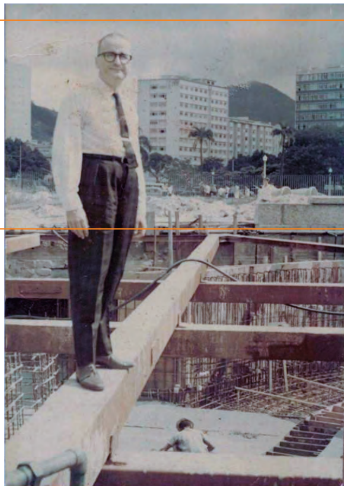
Início das obras do interceptor oceânico na altura da Praça Paris no início da década de 1970.
